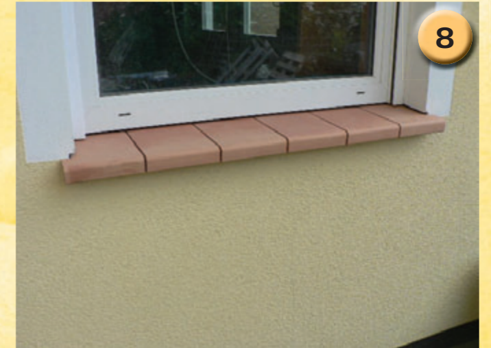
• Entfernen der Abstandshalter. Anschliessendes verfugen.
