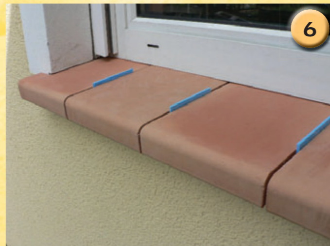
• Verkleben / Fixieren der Fensterbänke mit Hilfe von Abstandshaltern
