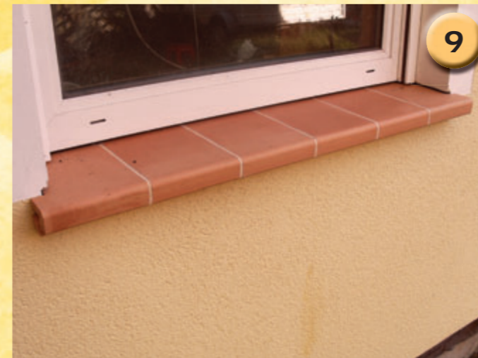
• Evtl. Imprägnieren der Fensterbank & Fugen
