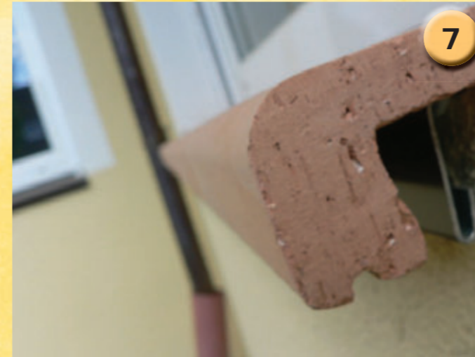
• Ausrichtung der Tiefer
