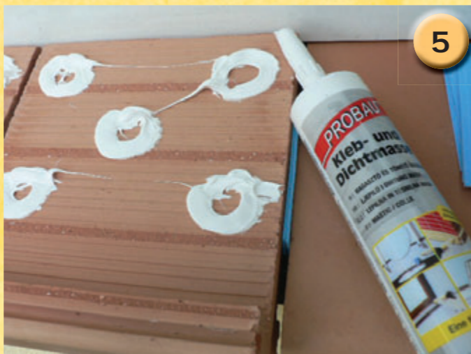
• Fensterbänke mit Baukleber vorbereiten
